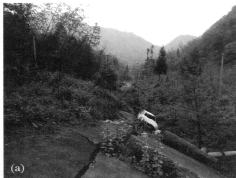
图 2 (a) 白沙河深溪沟公路两旁西北地块相对于东南地块上升了 3~4 m; (b) 深溪沟河床纵剖面
