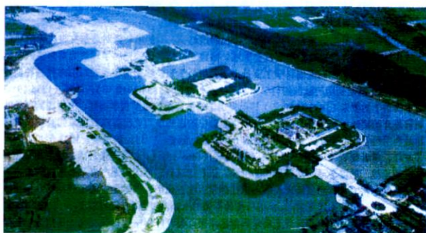
图9 南水北调东线工程江都水利枢纽 (新华社, 孟宝江、李力原图, 2007)
